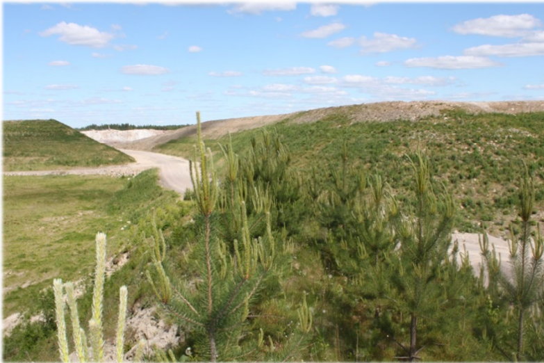
Kuva 5. Suojavalleja ja istutettuja taimia. Suojavallit ja metsä kohoavat louhintatason (kuvassa louhinta keskellä takana näkyvässä) yli suojaten tehokkaasti louhintatoiminnan äänen ja pölyn leviämistä ympäristöön.
