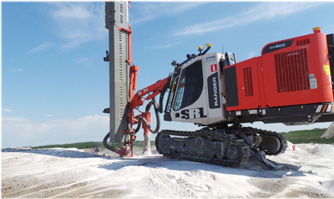
Kuva 12. Poravaunun pölynpoistojärjestelmä ja melukotelo.
